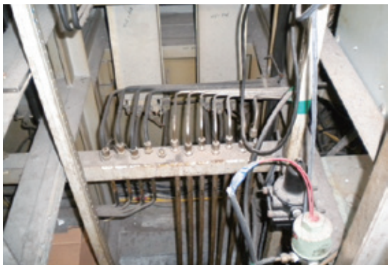
▲第一代的氣動式儀控系統，面板背面為密布的空氣管，目前亦已少見。（攝影：黃文賢）
