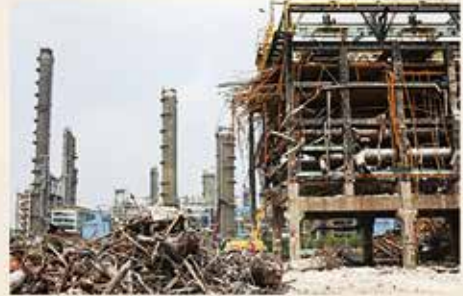
拆除中的工場
