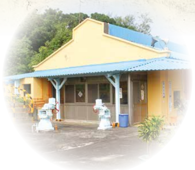
▲揚水泵房，源源供水 70 載。（攝影：歐文豐）
