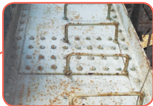
▲ 修造廠房樑柱上密密麻麻的鉚釘，見證高廠厚實的維修能力。（攝影：黃文賢）
