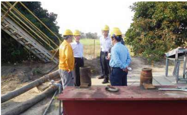
▲南區營業處陳世宗處長（左2）、錢明雄副處長（左3）2月視察HDD工程施作。
