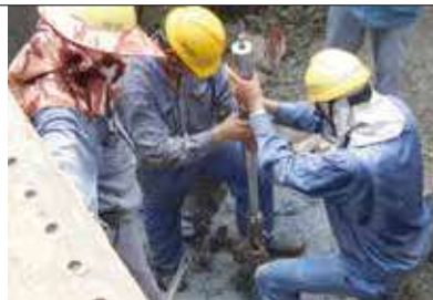
▲加壓開孔 (tapping machine, 舊管在銜接前需確認管線無殘餘天然氣) 作業狀況。
