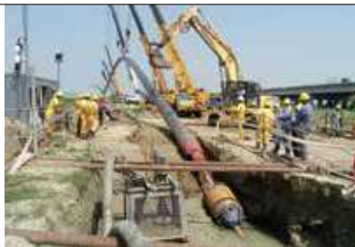
▲由到達坑回拉管至推進坑作業。
