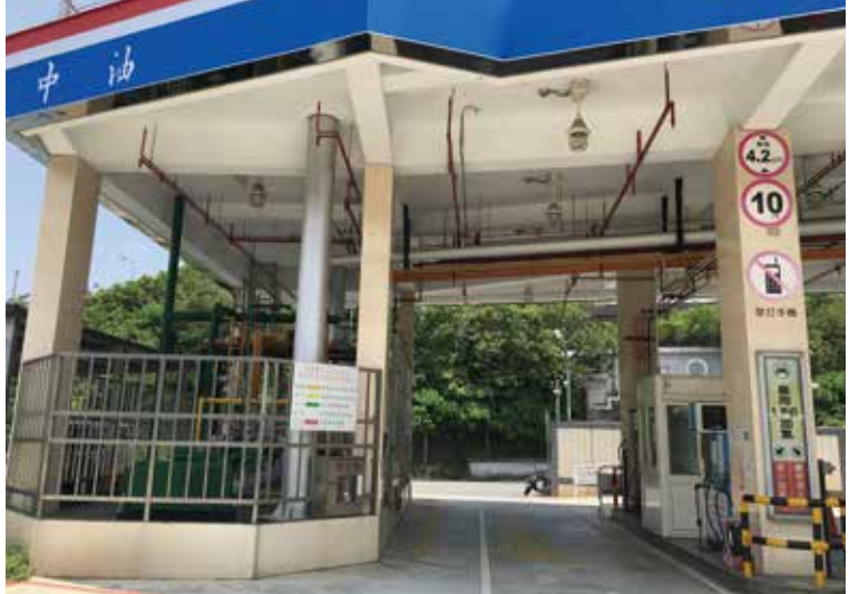
▲本公司濱江大直橋加油加氣站加氣區。
