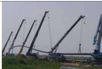
▲拉管時吊車作業的工程之美。
