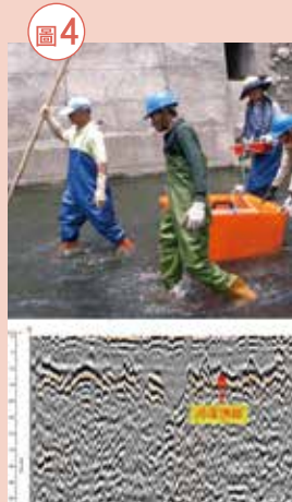
▲林園石化廠外台17號公路上之過河段河床管線探測調查。
