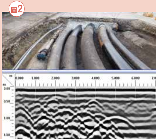
▲大林廠二橋油庫外高坪十一路透地雷達施測管線影像和開挖之管線群對比圖。
