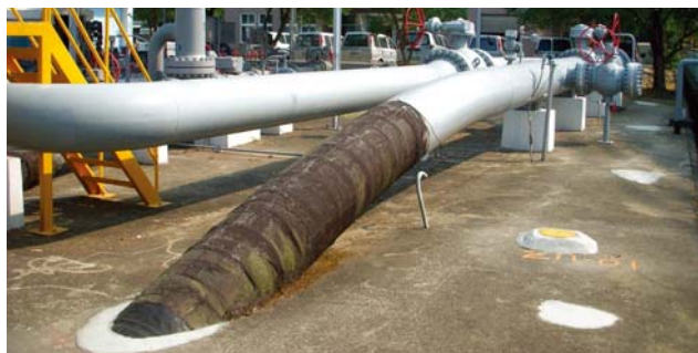
森霸電力股份有限公司豐德電廠 24 吋輸氣管線起點，位於中油公司天然氣事業部南區營業處台南供氣中心台南配氣站。
