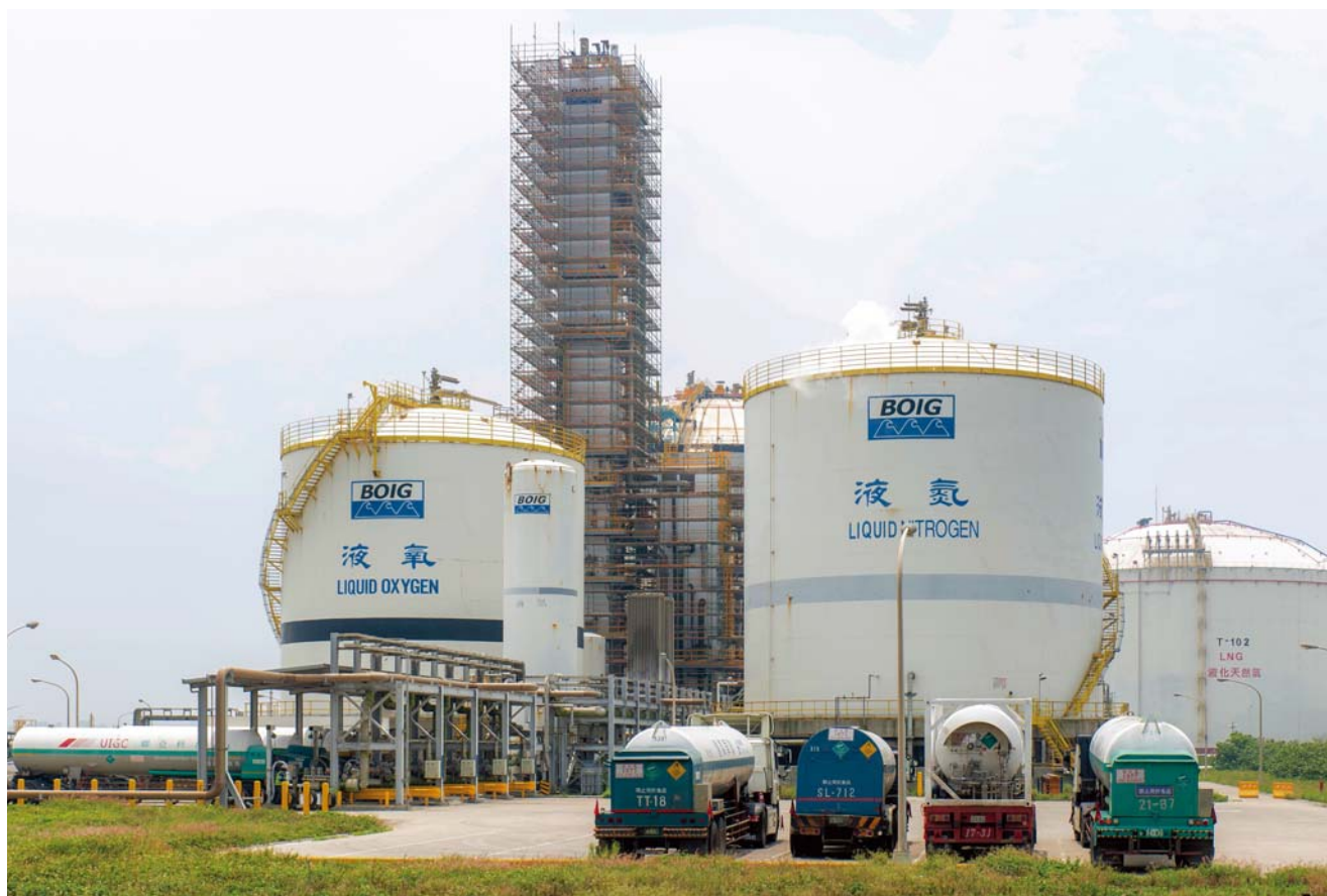
藍海氣體公司位於台中港區，緊鄰中油台中液化天然氣接收站。
