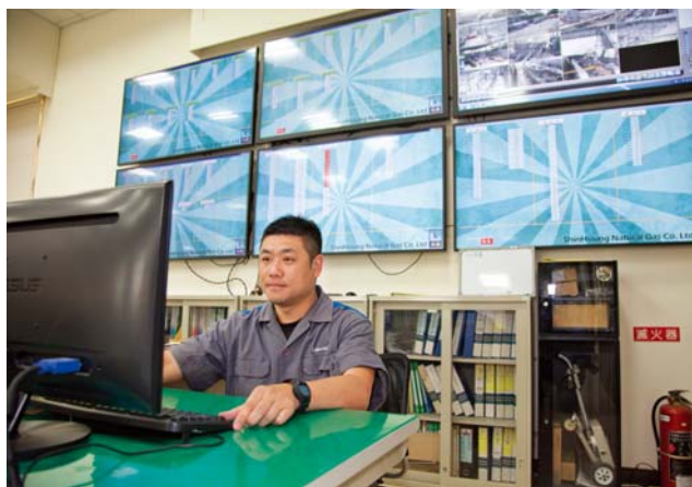
欣雄建置雲端系統，即時監控各地設備係數，一有異常狀況就能馬上得到警示，及時處理。
