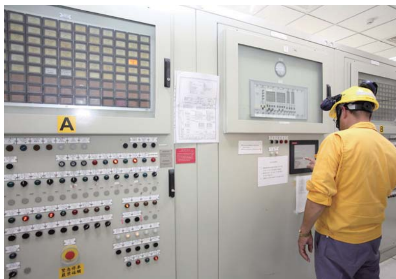
儲氣窖走向自動化作業，可從注產氣井中的設備監控目前注氣狀態。
