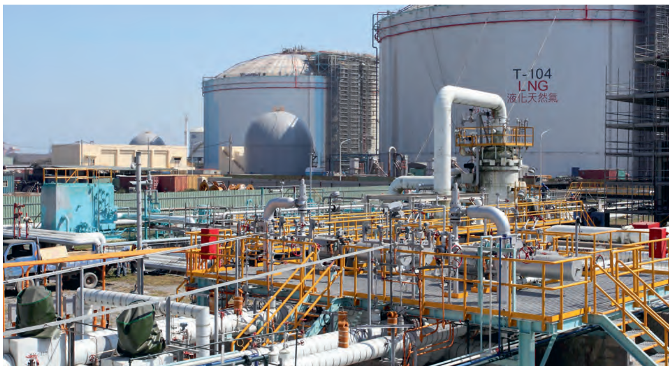
台中廠現有設備已不敷需求，因此推動二期擴建計畫，興建儲槽、氣化設施及管線，擴大天然氣儲量。
