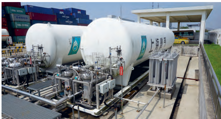
由於長途管線鋪設不易，通常會先將LNG卸貨於LNG衛星站的儲槽中，再以地方的管線提供給當地民生及工業用戶。（圖為上海洋山港儲備車用灌裝站的LNG儲槽）
