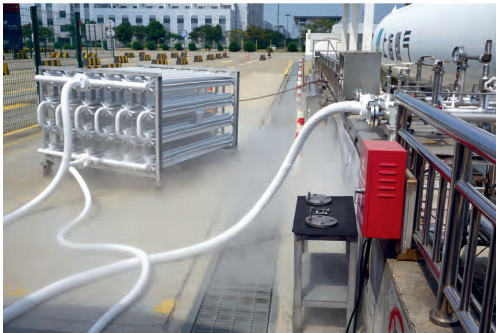
LNG 卸載氣化加壓器。
