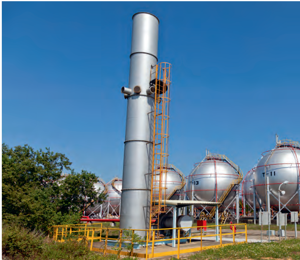
銀白色的儲氣槽於苗栗鐵砧山注儲區已服役近半世紀，風雨無阻擔負儲氣的重責大任。
