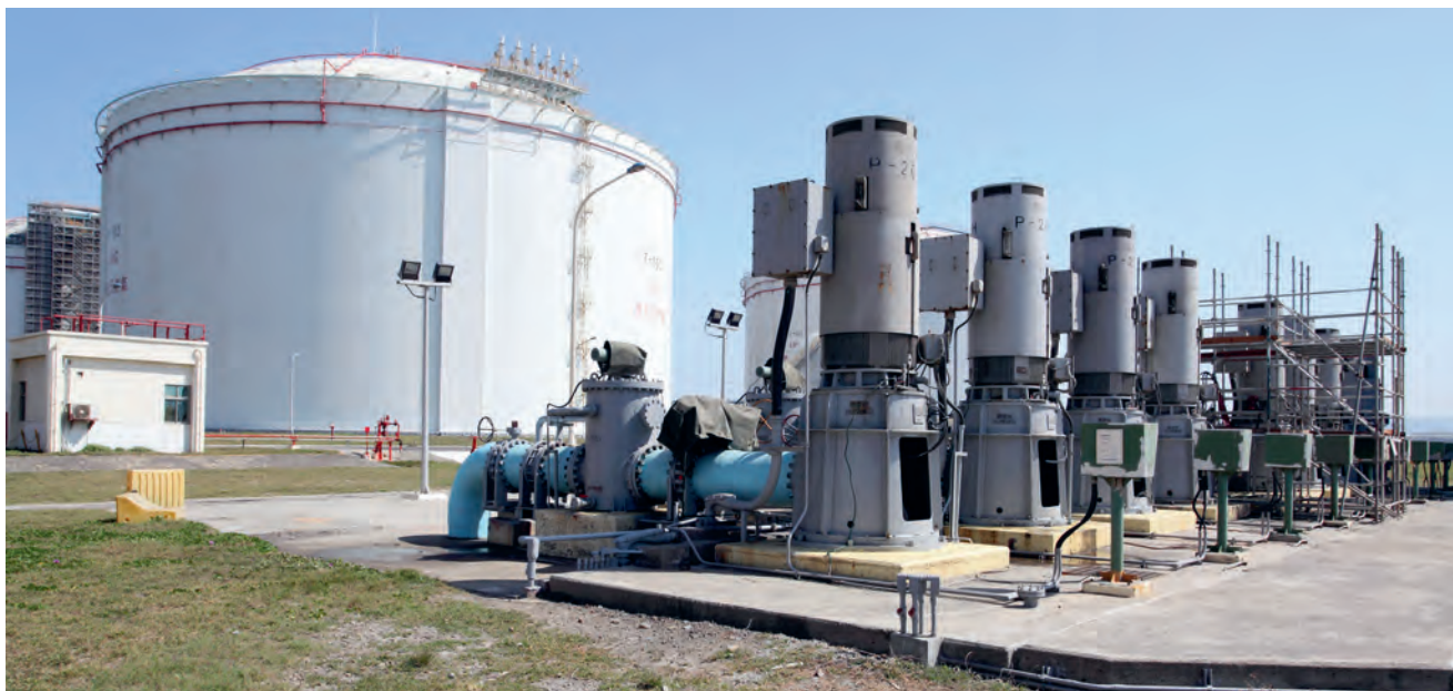
邁向非核家園、追求乾淨能源的台灣，需加快腳步擴充天然氣輸儲處理設備。圖為台中液化天然氣廠。
