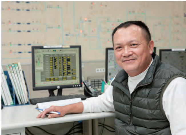
大潭配氣站站長莊育賢表示，站內採用DCS電腦控制，並由同仁輪值監控，隨時確保天然氣穩定供應。
