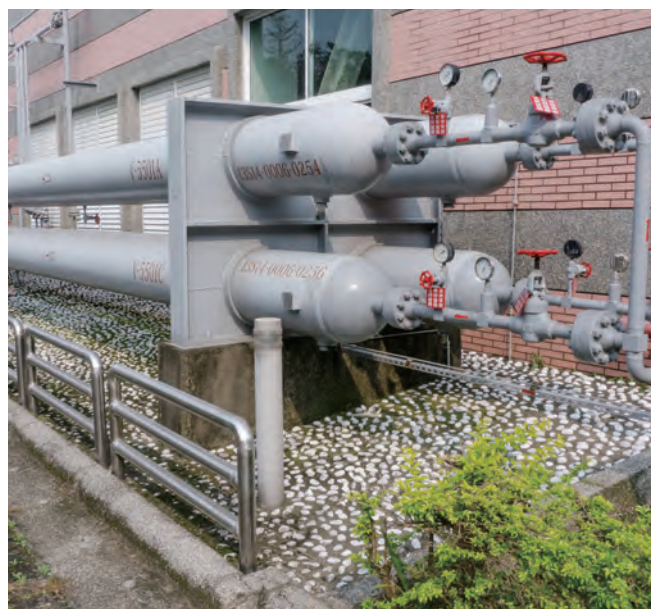
公用高壓儲氣槽依法須設置在戶外，用於儲存壓縮機加壓後之空氣。
