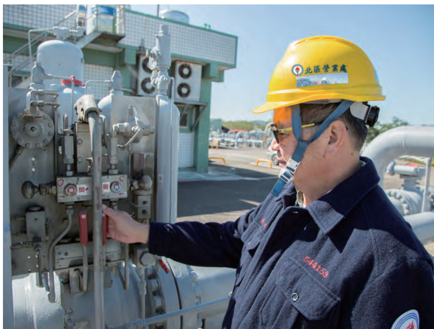
天然氣的管線巡查、維護、檢測及基本修繕等，是管線監理員的重要任務。
