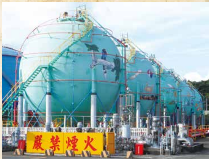
▲液化石油氣高壓球槽。（攝影／許順市）
