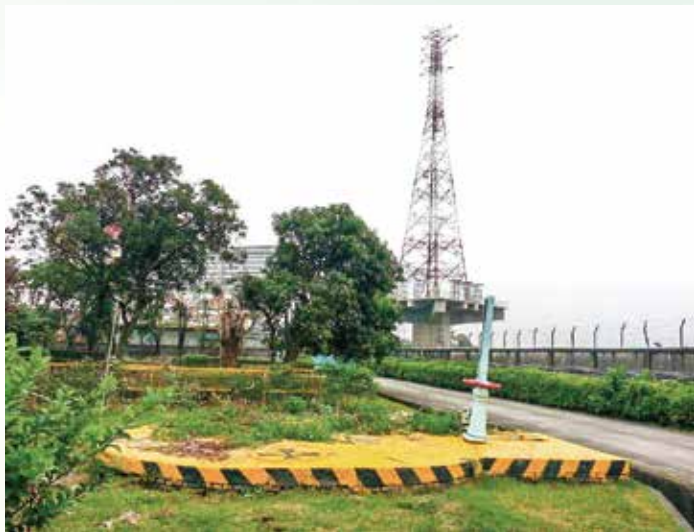
▲大寮水源站集水井外觀。
