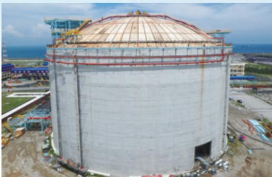
▲興建中的地上型儲槽內壁施工接近完成階段的外觀。
