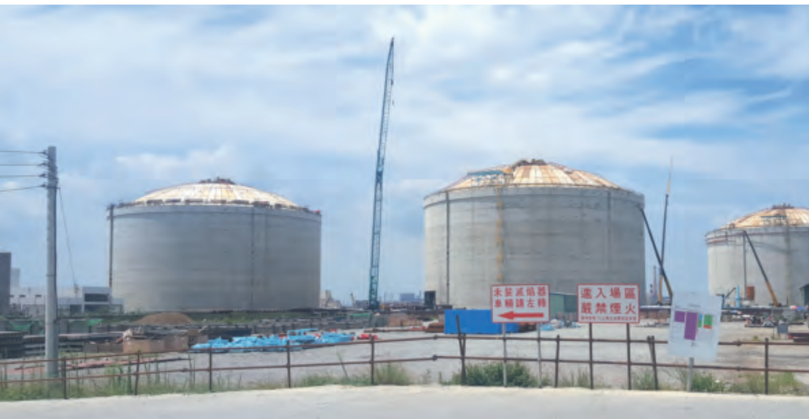
在台中廠一期投資計畫中，就已經興建了三座16萬公秉的地上式儲槽，以供應大潭電廠以及台中地區民生用氣使用。
