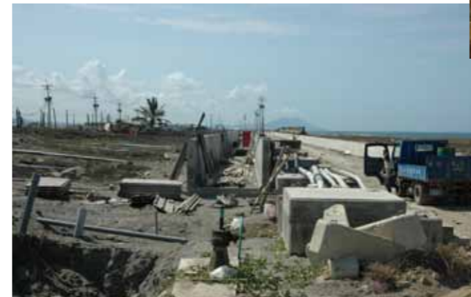
第四期工程管溝施工情形
