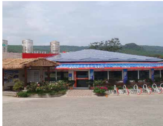
墾丁加油站—本公司首座太陽光電發電加油站
