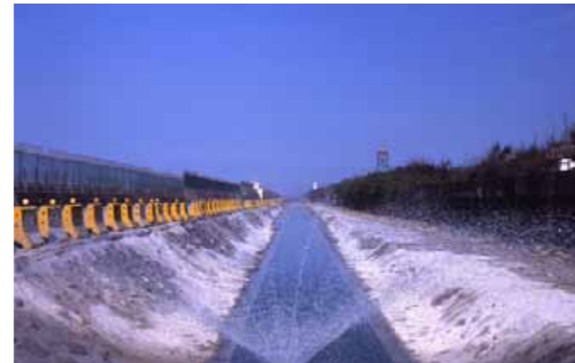
永安廠供應冷排水引水渠道
