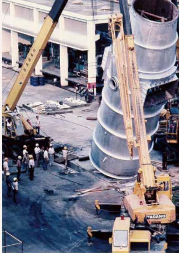
▲ 63 年廢氣燃燒塔組裝。
