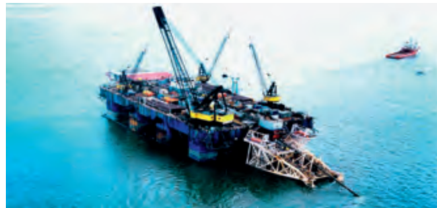
海管施工過程中，佈管船是不可或缺的角色。
