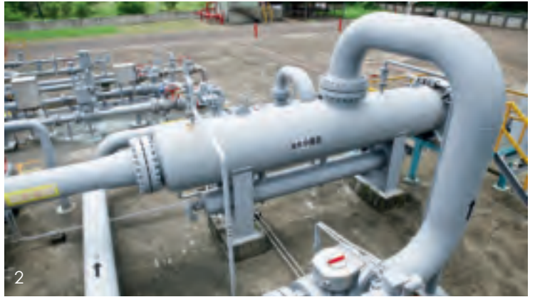
2. 錦水礦場、出磺坑礦場與鐵砧山礦場的自產氣輸送至苗栗供氣中心後，會先經過油氣水三相分離器，將油、水與天然氣分離。
