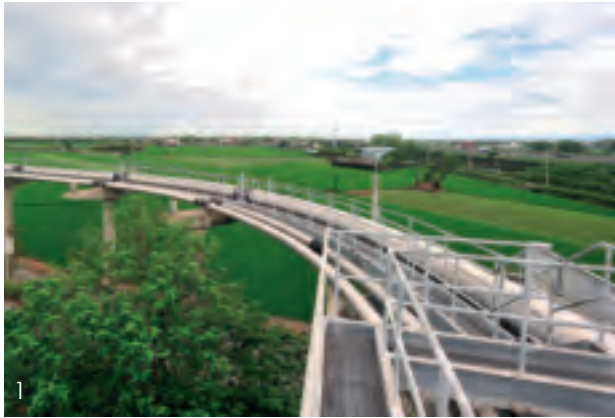
1. 全台唯一的陸上輸氣幹線管架橋，將天然氣由南往北輸送。
