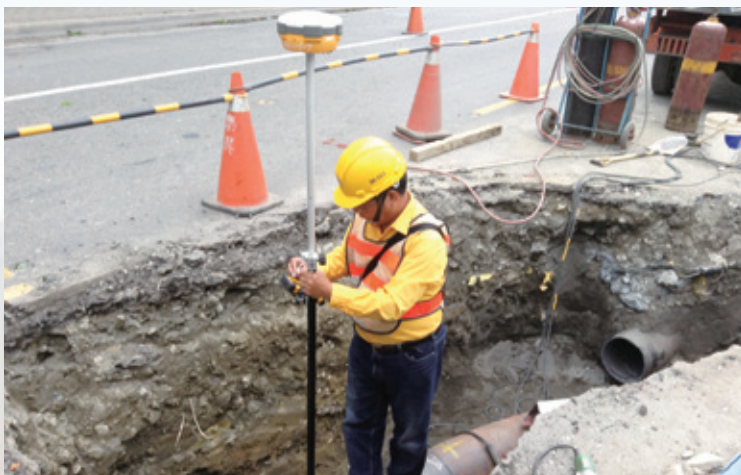
▲開挖驗證工作，測量隊同仁進行管線定位作業。 （照片提供／邱敦誠）
