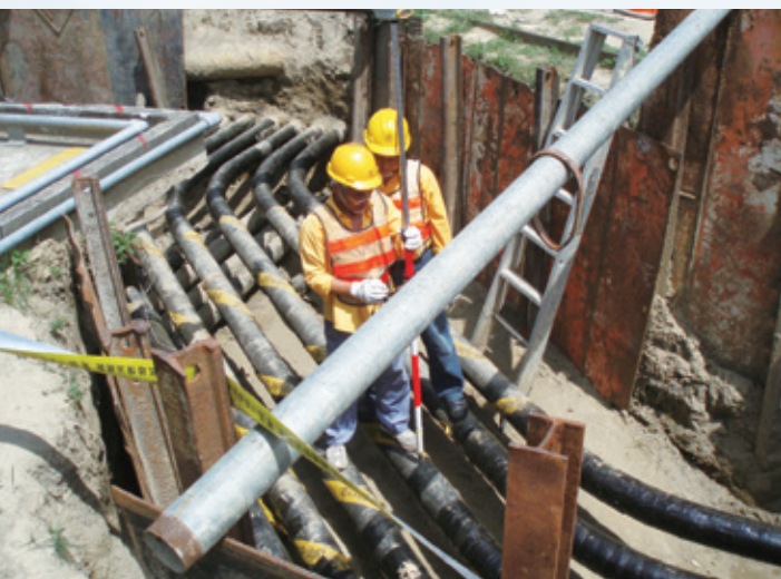
▲高廠管群施測。（照片提供／邱敦誠）
