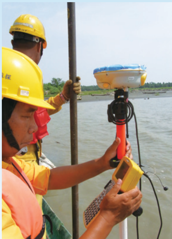
▲雙園大橋 HDD 導鑽控制點放機測量。 (照片提供／邱敦誠)
