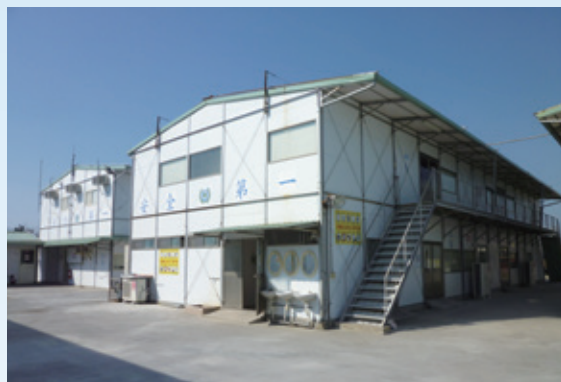
▲台中港工地鐵皮屋工房。
