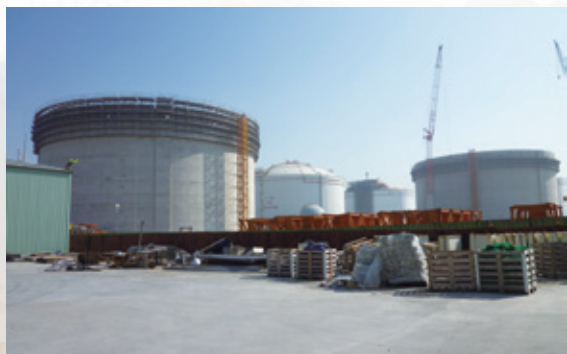
▲台中廠二期工地一隅。
