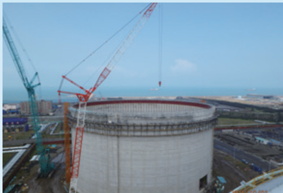
▲編號 T104 的天然氣儲槽，正進行屋頂骨吊掛作業。
