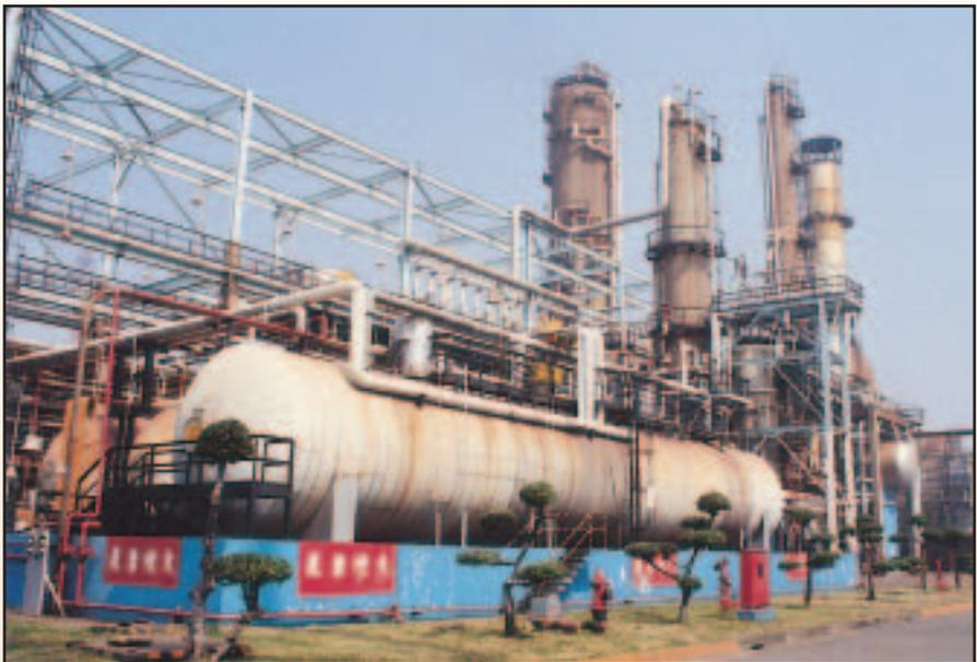
改為直接進槽方式，只要降低主塔頂部溫度，當壓力固定時，重石油腦(H-Z)及煤油便能以達到合於進料規範的比率入槽，不需人工摻配，可大幅減少停爐待料時間，提高油槽調度彈性。在鹼洗塔、砂粒塔差壓偏高方
