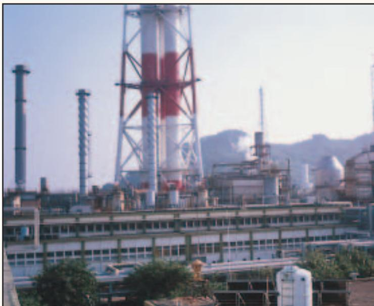
象，全廠高壓蒸汽壓力驟然降低，一時之間自有發電機組無法全額發電，經再度啟動內部解聯，終能維持供應停電期間全廠水、蒸汽、空氣、緊急電源等公用物料。此次自保方案雖未竟全功，然內部解聯即時保住公用系統持續運作，俟電力恢復立即供應開爐，使停電損失降至最低，可說達成初期目標。
