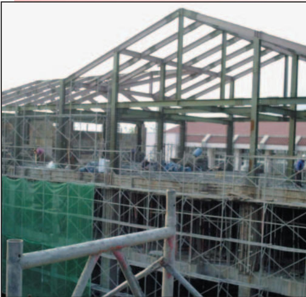
▲ 中油重建工程隊進行三樓版配筋、模版組立及混凝土澆置。（攝影：劉晟熙）
