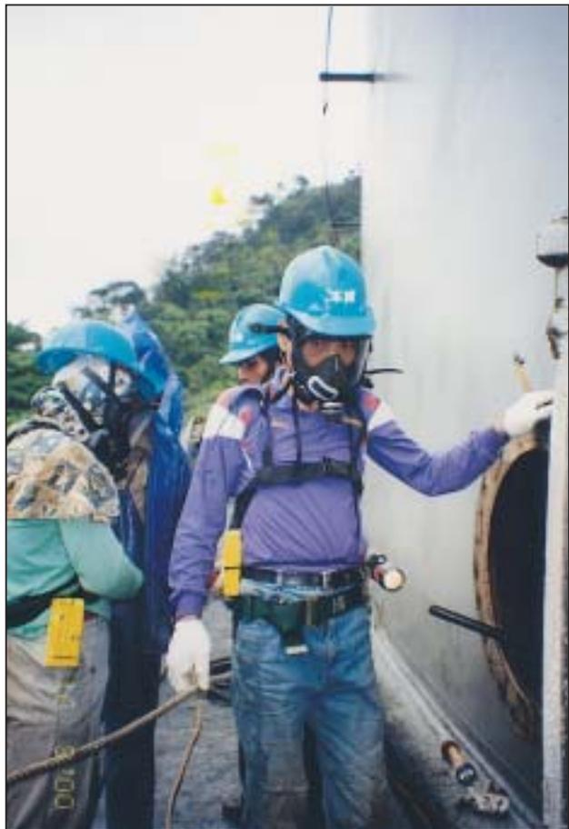
▲進入油槽進行清洗作業前，確認配備安全。（照片提供：安環處）
