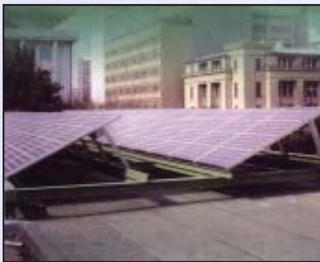
示範計畫方式合作進行，而由於總統府被列為國定古蹟，考量其整體風貌之維護，不容動其一瓦一木，系統架設選定於右側力行樓頂（如附圖），系統能量為一〇千瓦，系統高度為一·三五公尺，占地面积為一四五平方公尺；整個系統總共由一四〇片單晶矽模板組成（每片模板輸出功率為七五W，每片模板由卅六個C組成），模板分為三組，由三個充電器外蓄電池充電，再經由兩個直交流轉換器將48V-DC轉為220V-AC（單相三線）輸出，每一個
