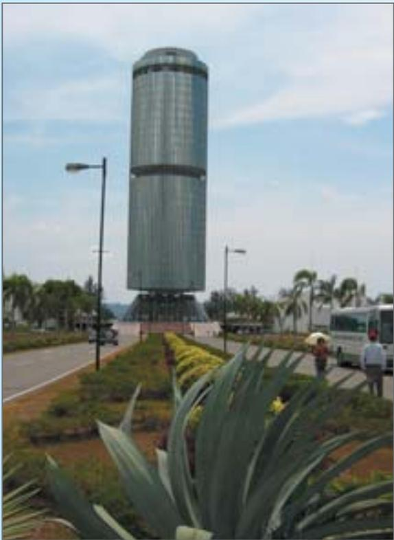
▲沙巴基金局為世上少數以一支主幹軸體、由九十六支鋼條呈輻射狀支撐的圓柱型建築。
