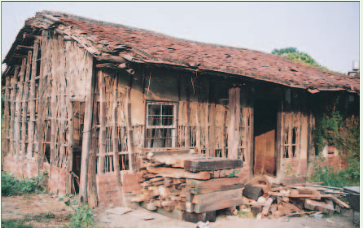
▲ 早期台灣傳統建築中，以竹、木、石灰等搭建的「柱仔腳厝」（攝於橋頭地區）。
