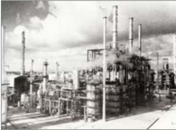
▲ 台灣首座輕裂工場（一輕）於民國57年完工，開啟石化發展之先河。
