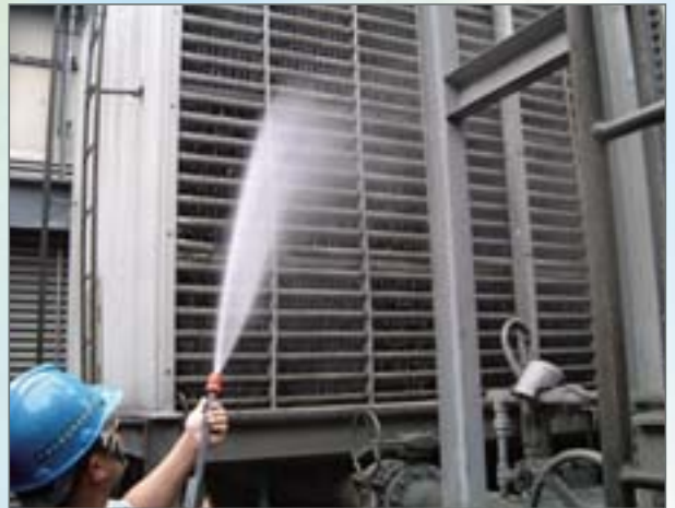
▲ 冷卻水塔清洗。（攝影：侯富安）
