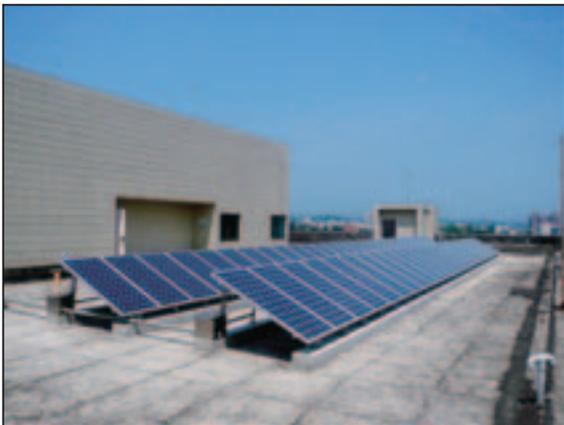
陽光照射在太陽電池(Solar Cell)上，直接轉變成電力輸出的發電設備；在發電過程中，無噪音、無廢氣排放，亦不會產生污染，堪稱理想的環保再生能源。目前此系統設置可獲經濟部能源局補助一半費用，十分適合作為輔助電力。（翁美貞）
