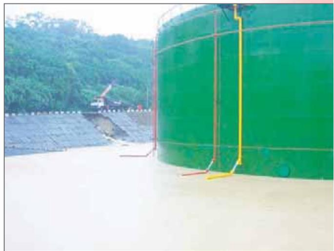
▲ 民雄供油中心防溢堤塌陷達13米，泥水湧入。（照片提供：嘉南營業處）
