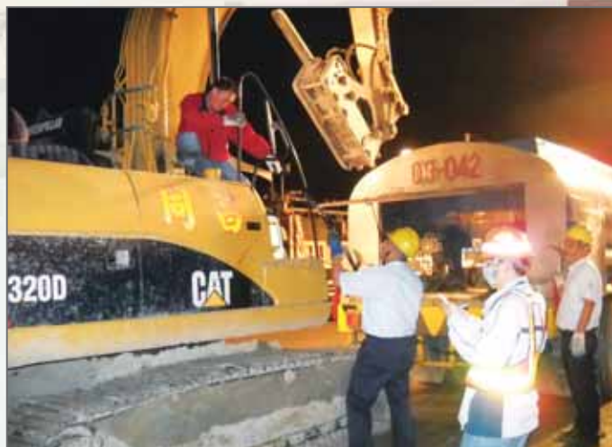
▲ 流動加油油罐車為挖土機加油。
