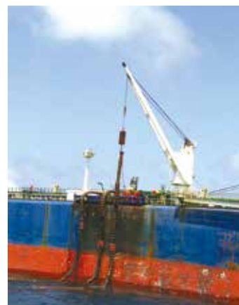
▲「浮筒班」已接好兩條浮蛇管，在大型懸吊機具的協助下，進行最後一條浮蛇管接管工作。
