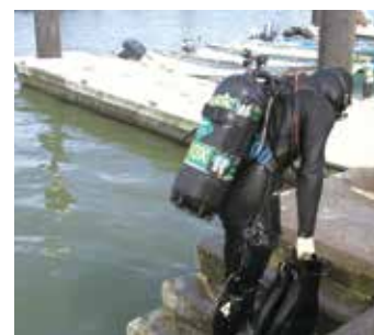
▲海底管線的維修工作，必須仰賴潛水員潛入海面下進行。
