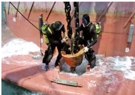
▲潛水員鎖固卸油浮筒固定鏈條。
