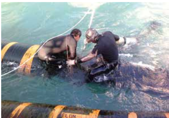
▲潛水員鎖固卸油浮蛇管螺栓。
