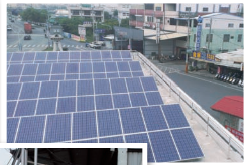
社頭站多晶硅太陽能發電板
