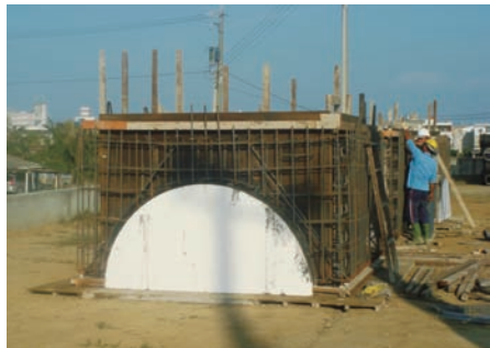
箱涵預置工程，箱涵可減少輸送途中冷能的逸散
