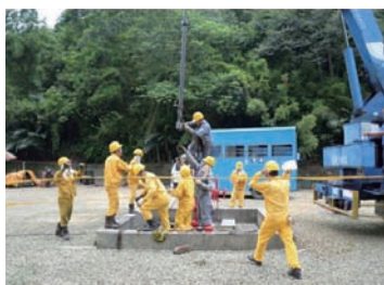
二氧化碳地質封存設備安裝及測試
