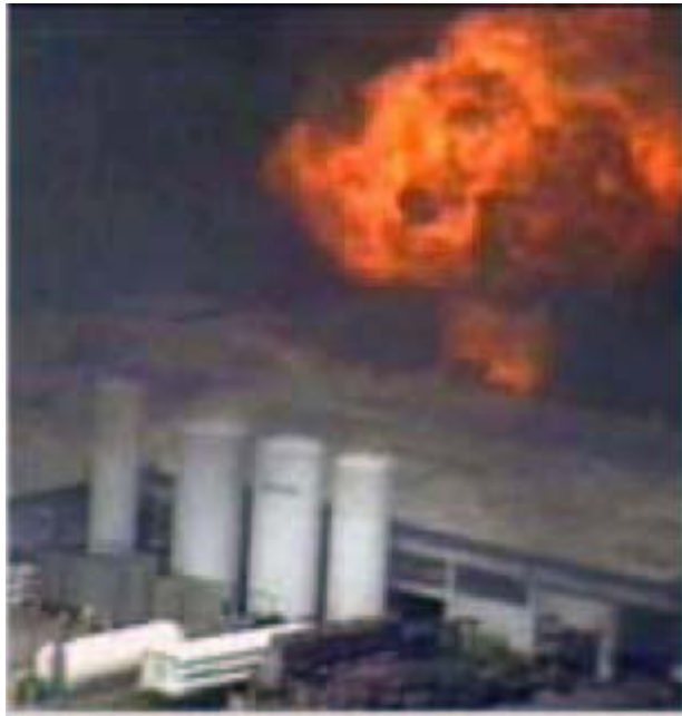
圖二、現場火災情形
