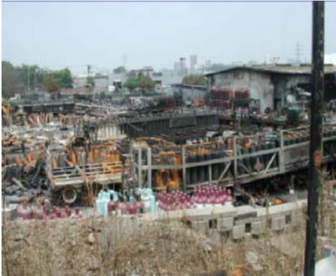
圖六、事故現場損壞情形
