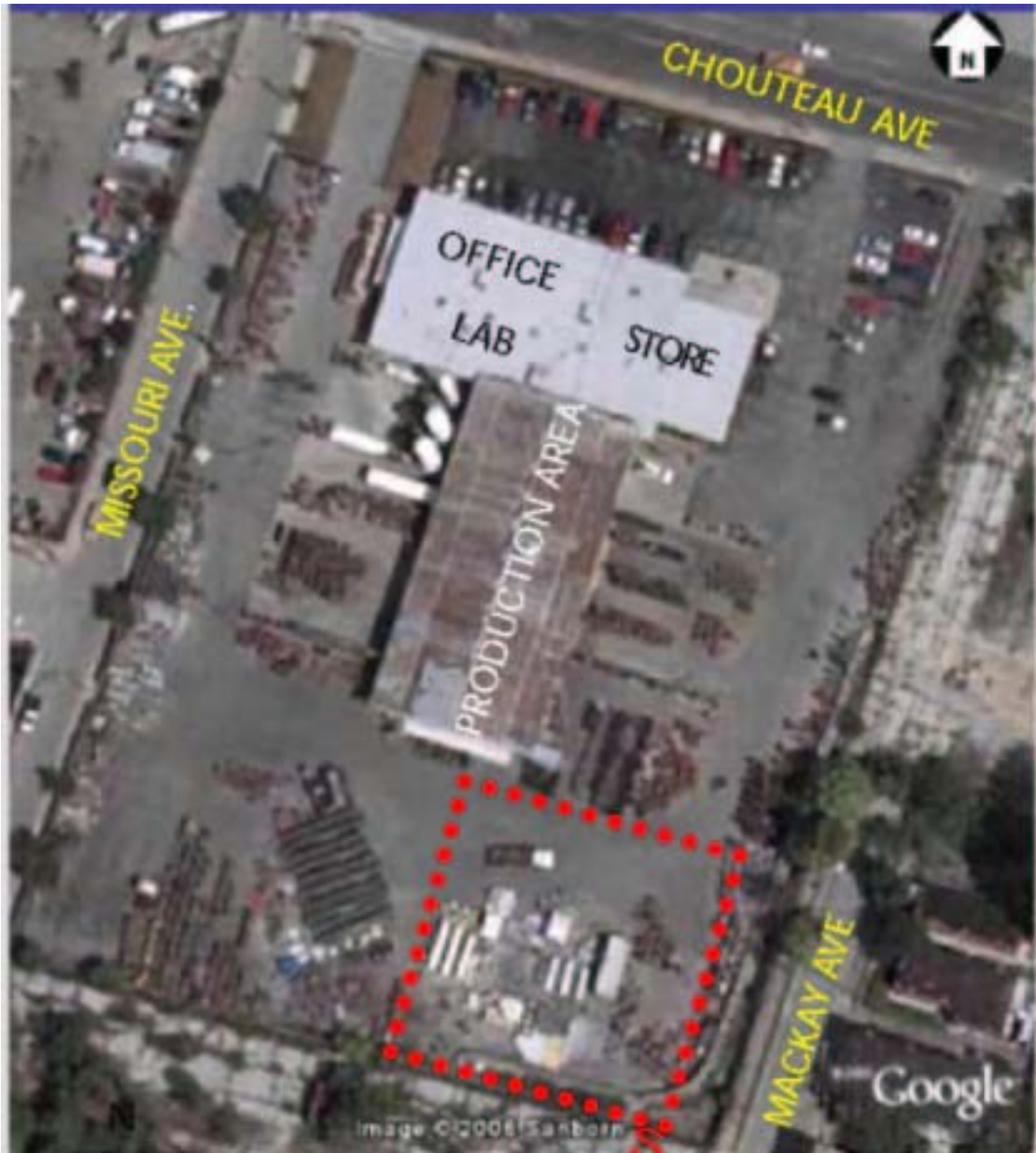
圖五、Praxair 氣體鋼瓶分裝場高空俯視圖，紅色框為其儲放鋼瓶區
