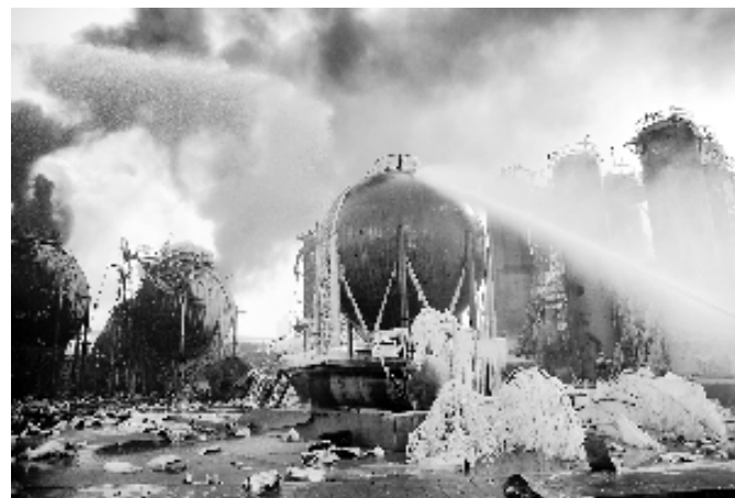
因液化氣儲罐本身冷卻，加之氣候寒冷，水砲噴出的水龍迅速凝結成冰，附著在罐體和管線表面
