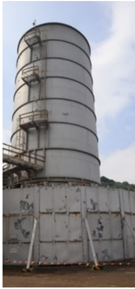
▲ 二輕地面燃燒塔
