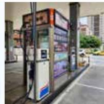
▲國光牌AdBlue車用尿素，散裝車用尿素加注系統。(照片提供／煉製研究所)
