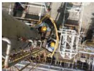
◀設檢中心人員對未拆除包覆之脂溶第三塔做脈衝式渦電流檢測工作。
