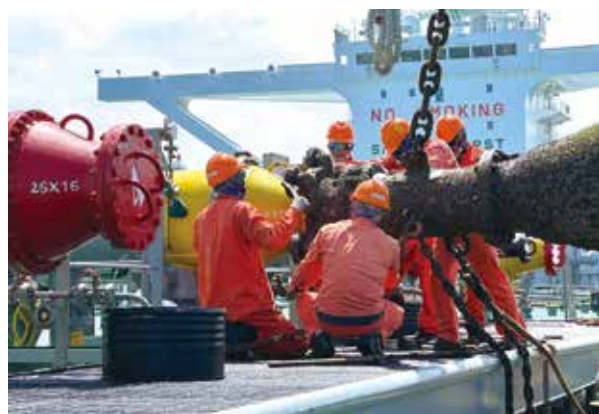
▲完成接管作業。
