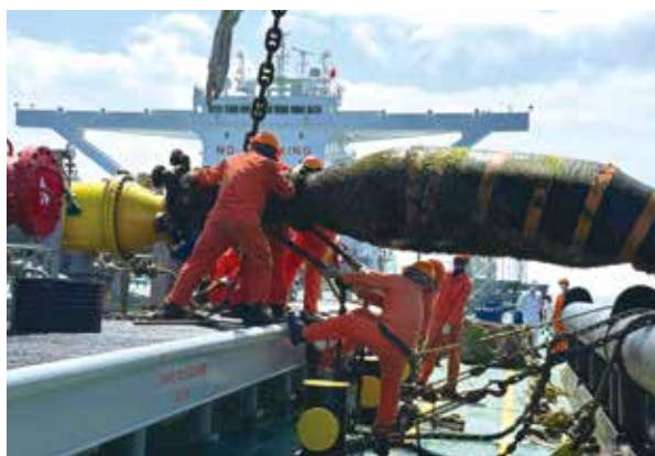
▲浮筒班同仁與原油油輪船工合力完成接管作業。
