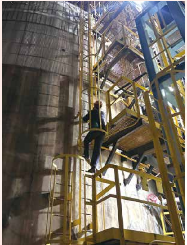
▲除夕夜石化事業部同仁爬上儲槽巡檢。
