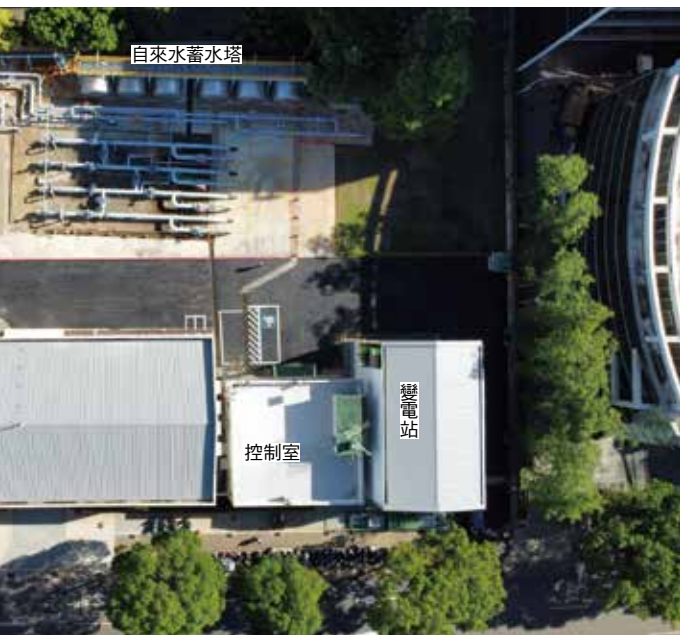
▲氮氣系統、摻配系統建置完成後，林口天然氣摻配中心空拍照。
