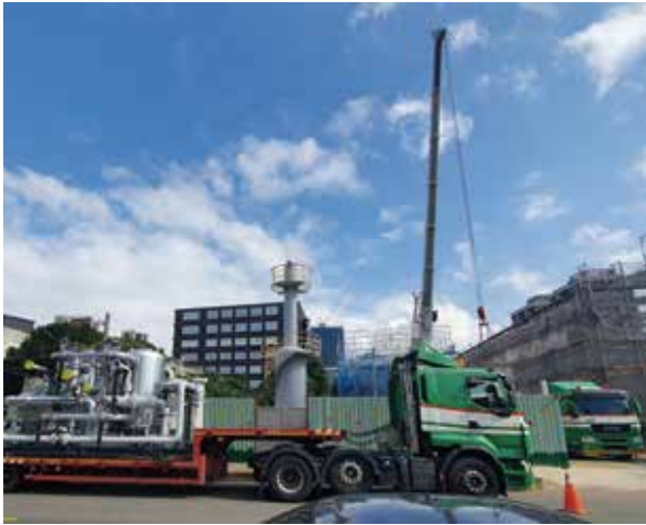
▲使用特殊板車運送氮氣系統設備。
