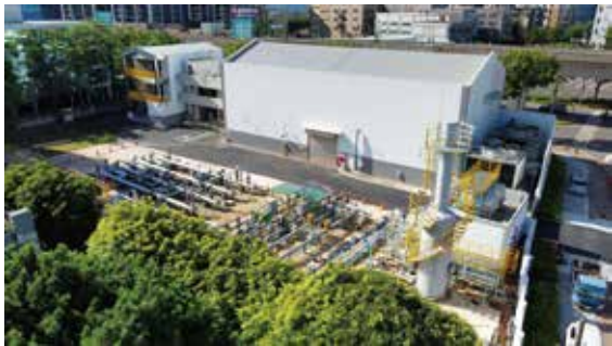
▲林口天然氣摻配中心空拍照（西北視角）。
