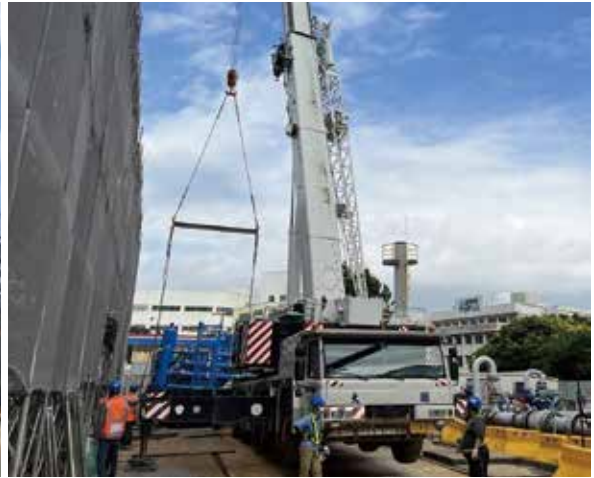
▲使用重型吊車進行氮氣系統設備吊裝。
