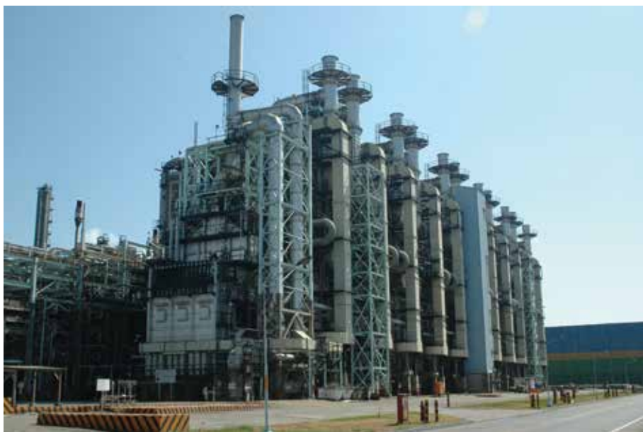
五輕裂解爐。 (台灣中油公司 提供)
