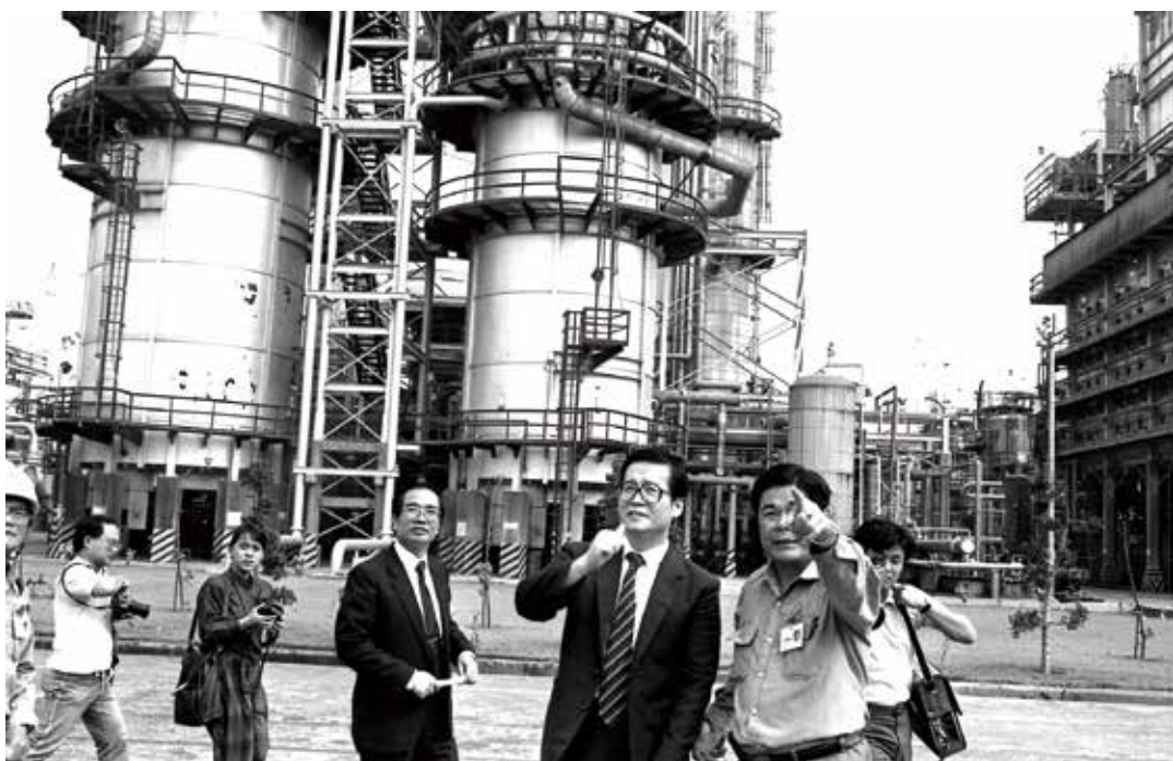
76年11月17日，行政院環境保護署長簡又新（前左）到中油公司高雄廠聽取工作人員說明汙水處理過程，並參觀各項設施。（中央社攝影）
