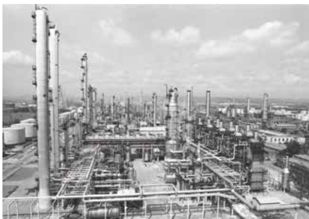
第二輕油裂解廠工場。(台灣中油公司提供)
