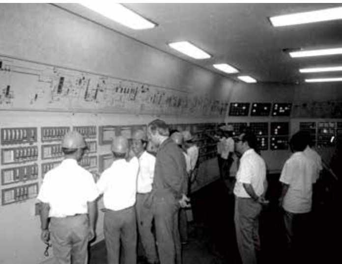
64年10月22日，中油公司在高雄煉油廠興建的第二輕油裂解工場，經過2個月的試煉，全部順利完成，正式開始穩定生產。圖為在控制室的工程師。 (中央社攝影)
