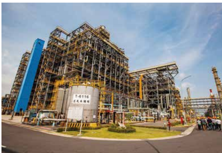
兼顧環保、節能與石化科技的新三輕工場。 (台灣中油公司提供)
