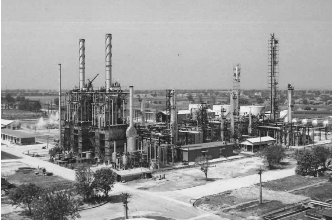
第一輕油裂解工場全景。（台灣中油公司提供）
