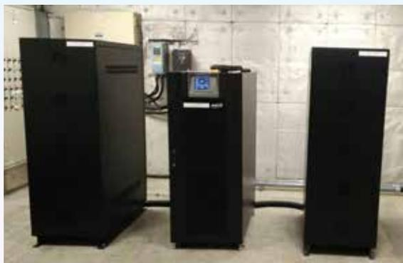
▲圖1A：設置於台北中油大樓的鈦酸鋰不斷電系統。
