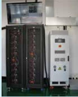
統額定容量為 60 kVA，並符合 IEC 62619 國際安全標準。圖 1B 為 110 年 5 月 13 日下午 4 時至 8 時之間的中油大樓供電監測，該日由於發生大規模停電事故，台電公司啟動低頻卸載保護機制，市電電網共發生 3 次斷電事件；在每次斷電後至柴油發電機上線運轉之間（約 30 ~ 40 秒），此不斷電系統皆即時補上供電缺口，因此用戶端電壓能穩定維持在 219.5 ~ 219.9 V。
