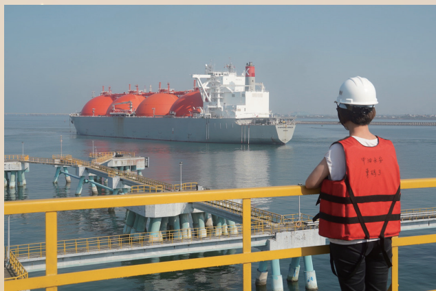
▲108年彭組長迎接交響微風號LNG船緩緩駛入永安港。
