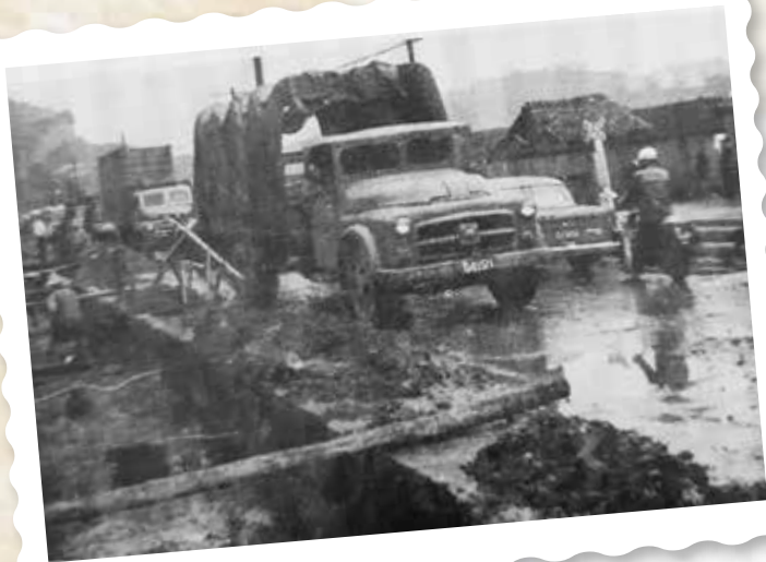
▲基隆至深澳管線施工現場。(照片提供／曾坤生)
