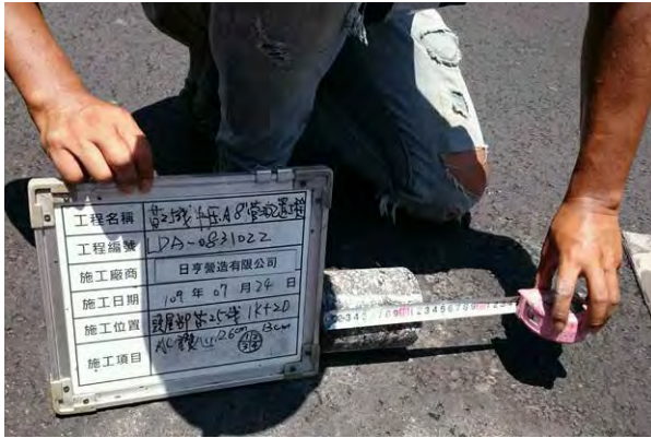
▲承攬廠商鑽心檢測瀝青厚度。
