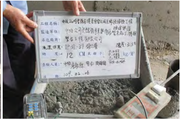
▲監造人員抽查混凝土氯離子濃度。
