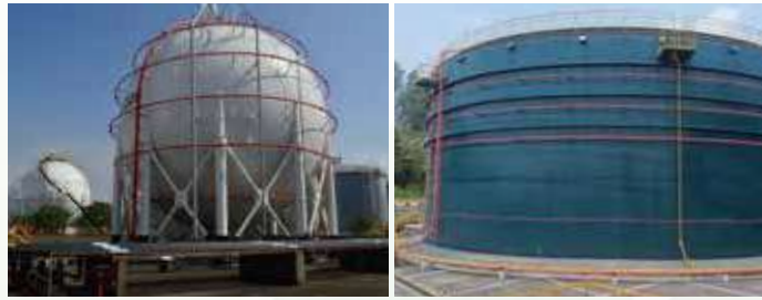
▲常溫重防蝕塗裝系統應用於前鎮儲運所（左）及民雄供油中心儲槽（右）。
