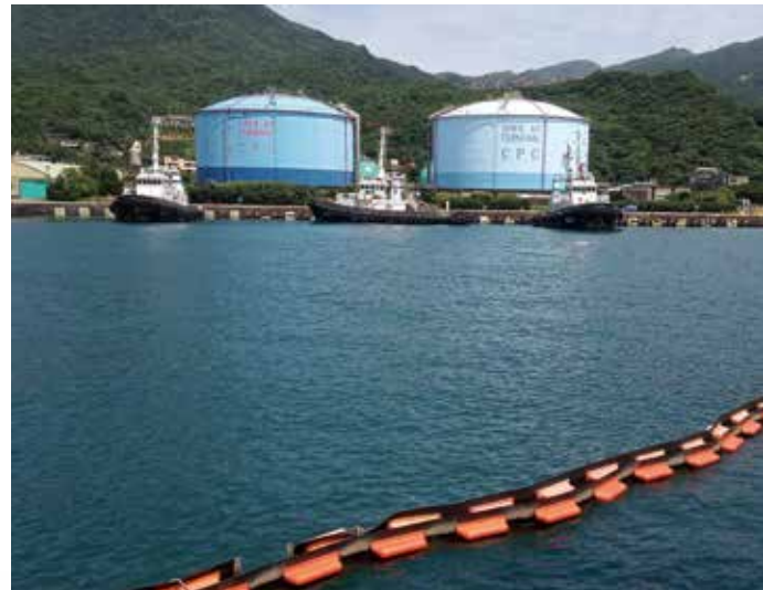
▲常溫重防蝕塗裝系統應用於高腐蝕、環境嚴苛的深澳港供輸服務中心儲槽。
