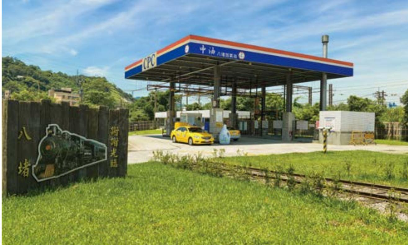
104年5月20日，基隆八堵加氣站獲頒「鑽石級」綠建築標章。103年9月啟動改善工程，在屋頂加裝雨水收集槽，以雨水灌溉綠地；照明改用節能的T5燈管；廣種高透水性植草地坪取代水泥地等，因而榮獲綠建築最高等級標章。截至110年4月，本公司共有63座加油站榮獲綠建築標章。
