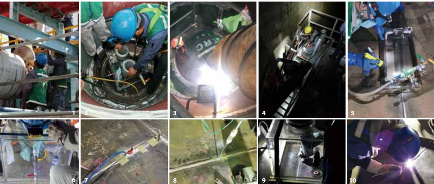
▲台中LNG廠T-105儲槽開槽檢修：1. 相關管線盲封作業。2. 於持續填充氮氣之盒子中鑽孔（開槽前作業）。3. 內槽人孔氣刨開槽作業。4. 第一次進槽內確認氧氣濃度。5. 真空盒試驗檢查。6. 於持續填充氮氣之盒子中鑽孔（底板檢修）。7. 從小孔灌注氮氣。8. 檢測底板下方是否有可燃氣體。9. 於持續填充氮氣盒子中進行動火研磨作業。10. 缺陷補銲。
