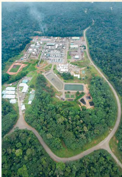
▲鳥瞰16號礦區南部生產處理中心。
