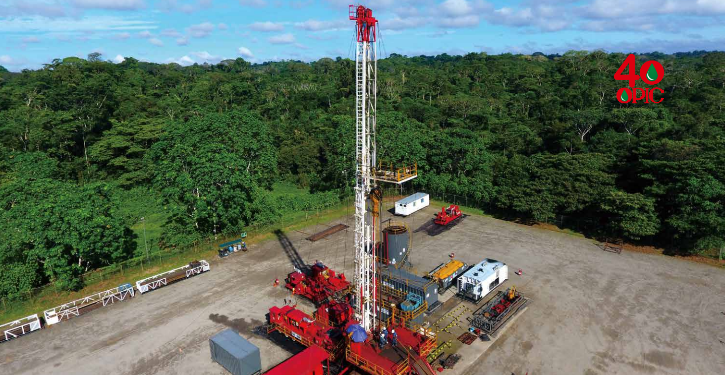
▲礦區生產平台，修井鑽機正進行修井作業。
