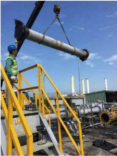
▲通霄轉輸中心進行超音波計量設備拆裝作業。
