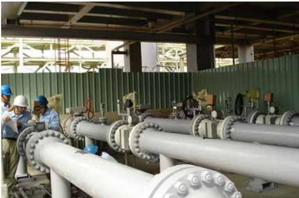
▲大潭電廠SICK 12" 超音波流量計標準件管線配置圖。
