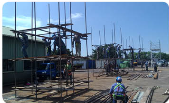
承攬商施工架搭架人員入工地前教育訓練術科操作
