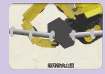
(3) 採用原有管線材質焊補或更換材料
