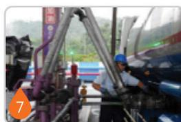
7 接好罐裝臂並打開底部罐裝閥及緊急閥
