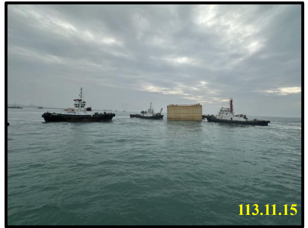
沉箱(#90)定位作業
