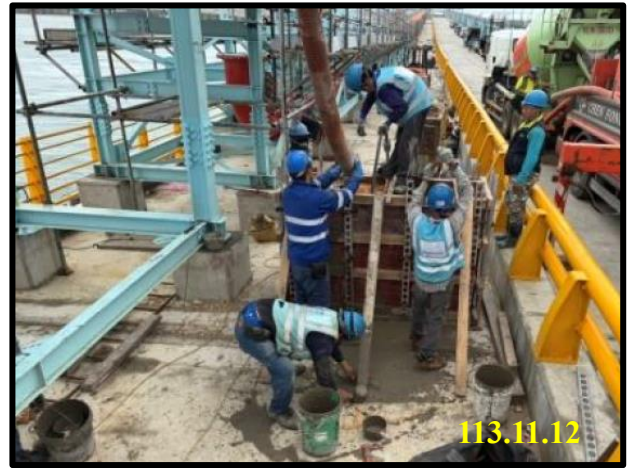
墩座混凝土澆置
