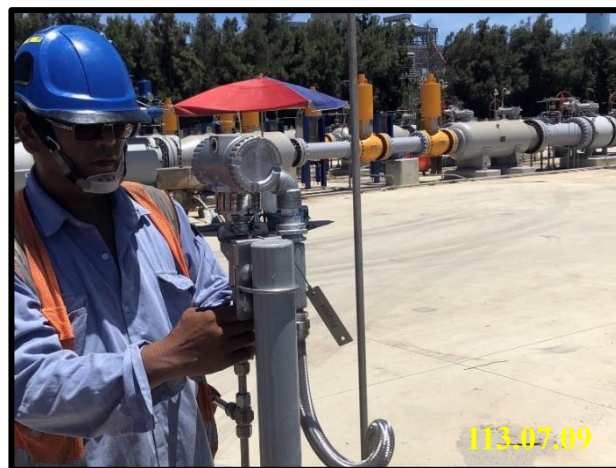
儀電配管拉線接設備
