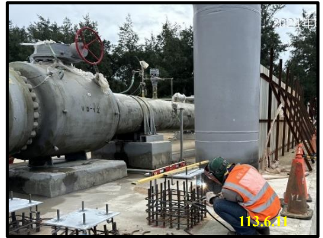
平台支撐施作
