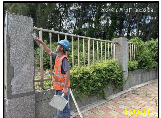
電廠一路圍牆修復
