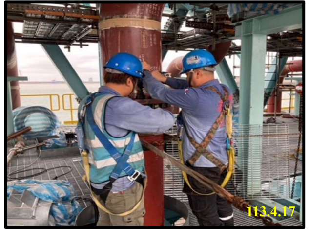
管線組立安裝
