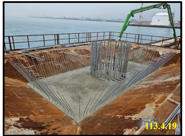
彎管平台第一層混凝土澆置
