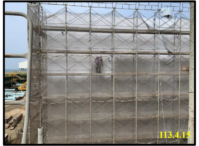
外牆油漆施作
