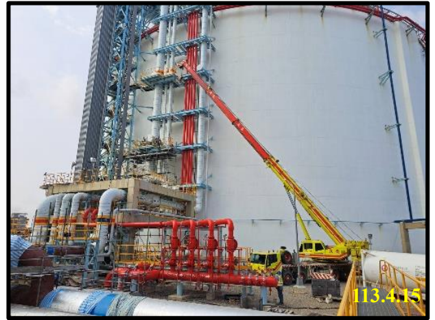
第 2 座儲槽 線槽施工架拆除
