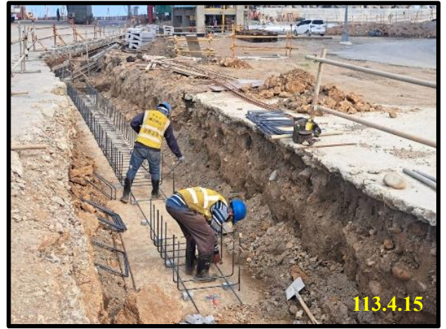
第 1 座儲槽 外環水溝鋼筋組立
