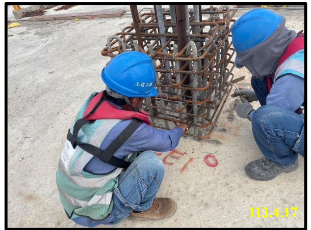
管架鋼筋綁紮
