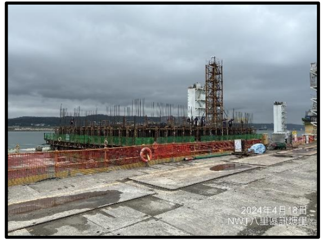
沉箱(BE-78)內艙及外模吊裝
