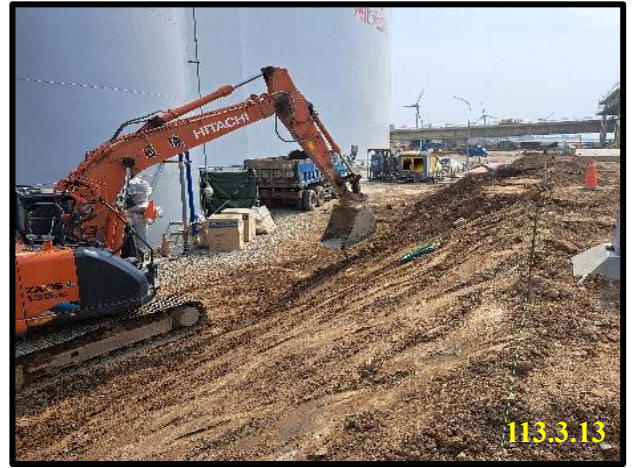
第 1 座儲槽 涵洞聯絡道路整地
