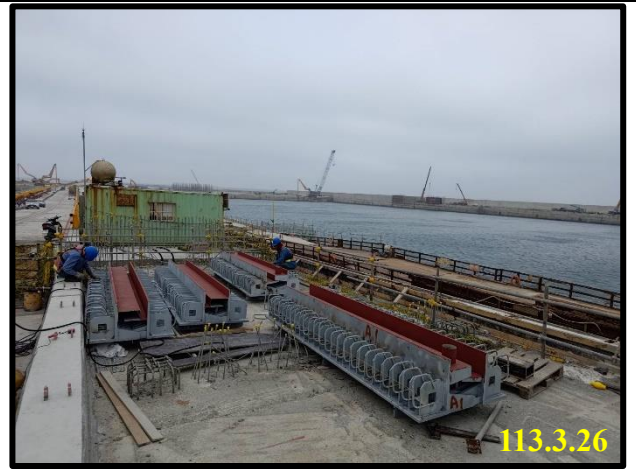
A1 橋面伸縮縫施作
