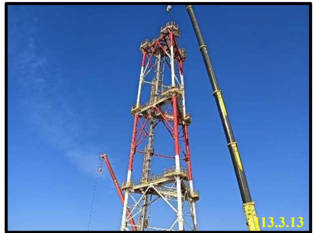
燃燒塔模組吊裝
