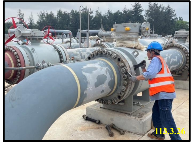
配氣站螺栓鎖固
