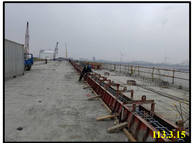
透空式護欄基座鋼模組立
