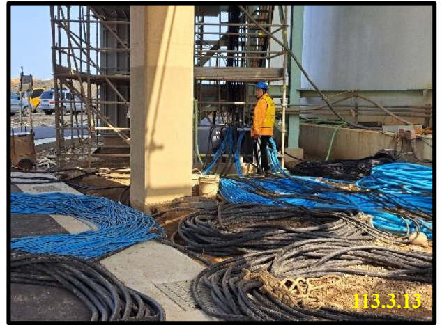
第 2 座儲槽 電纜拉設
