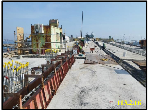
B27 透空式護欄基座模板組立
