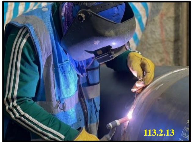
地下消防管銲接
