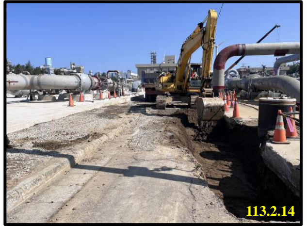
配氣站水溝復舊
