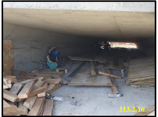
B33 箱涵底板拆模
