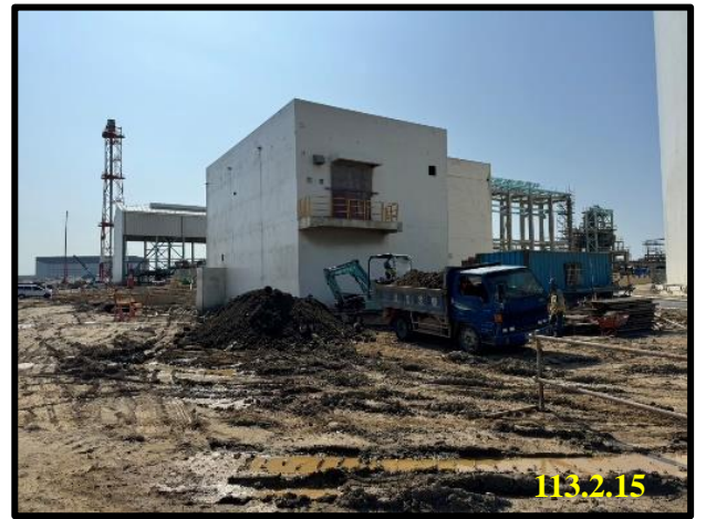
第 2 座儲槽 東側水溝開挖
