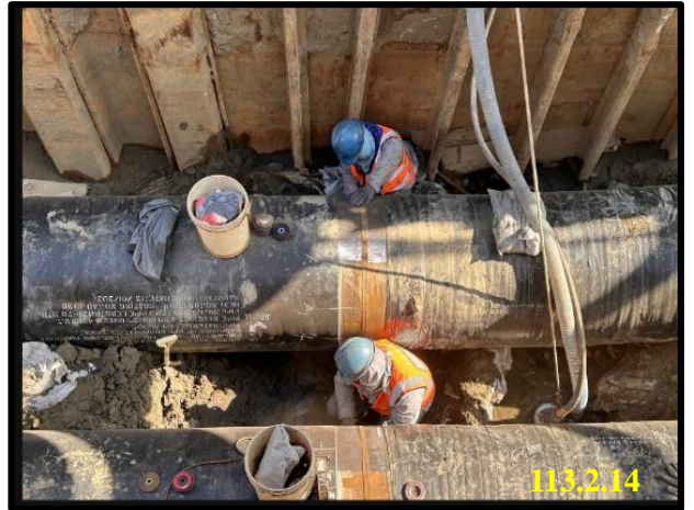
桃科二路管線除鏽包覆
