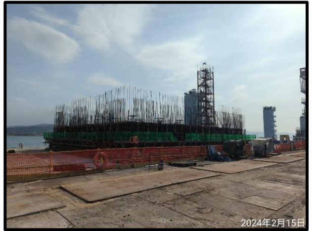
沉箱(BE-72)底板養護
