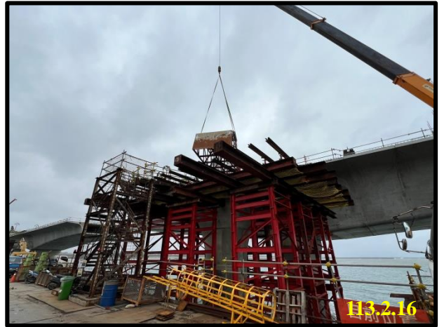
彎管平台鋼模組立
