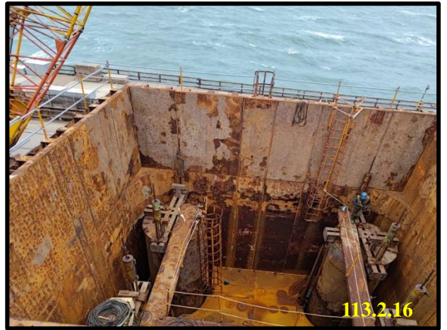
樁帽圍堰下放前置作業
