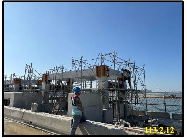
樑柱接頭施作
